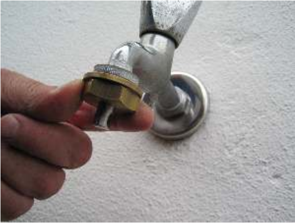
Schritt 1: Werkzeuglose Montage der Messing- Verschlusskappe mit innenliegender Dichtung
