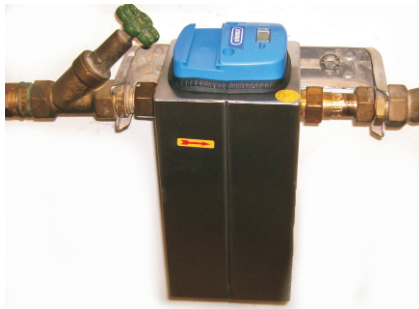
Robustes Edelstahlgehäuse mit geeichtem Zähler QN 2,5
