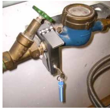
Sicherungssystem Alligator Sicherung an Zählerverschraubung Sicherung an Schlauchverschraubung
