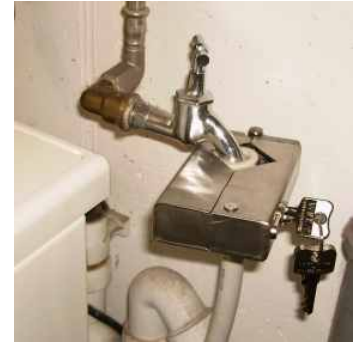
Sicherungssystem Alligator Sicherung an Zählerverschraubung Sicherung an Schlauchverschraubung
