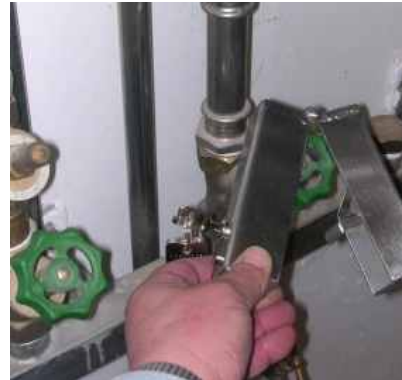
Handradabsicherung Absperrventil
