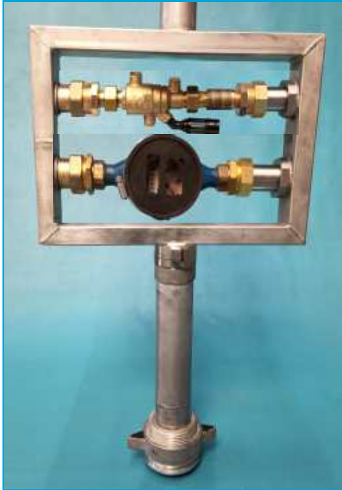
Optional: Zähler und Systemtrenner auf kleinere Dim Qn2,5 (Q4=5 cbm/h) bzw. DN 20 mit entsprechenden Adaptern umrüstbar
