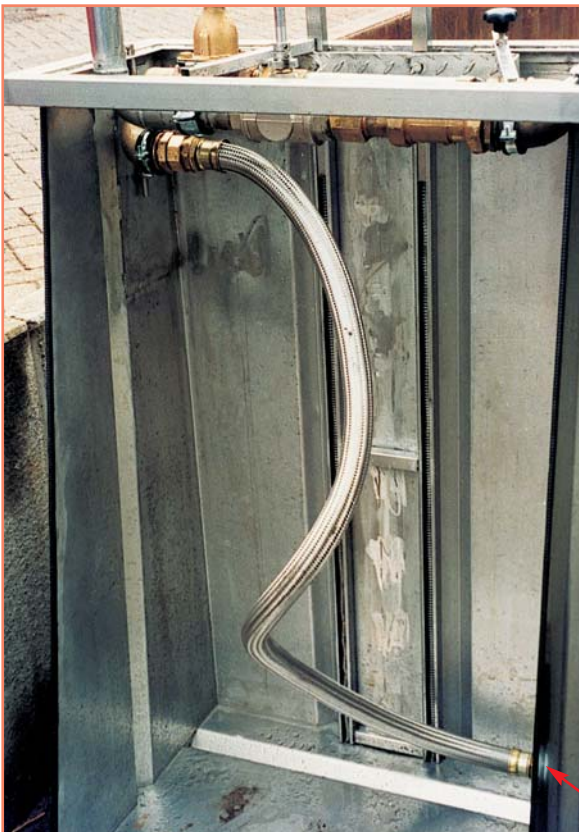
Einfacher Leitungsanschluß außerhalb Schachtkörper
